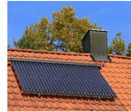
Solarthermie- Hybridheizung
